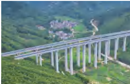
▲南湛高速簕竹头大桥
